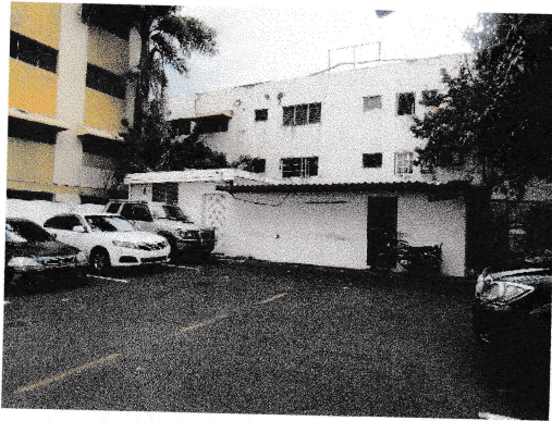
Caseta de la planta, almacén 1 de suministro, cuarto de electricidad y almacén servicios generales.
